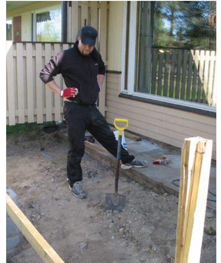
Kuoppakin kaivettiin käsin. Ei tarvinnut lähteä kuntosalille...
