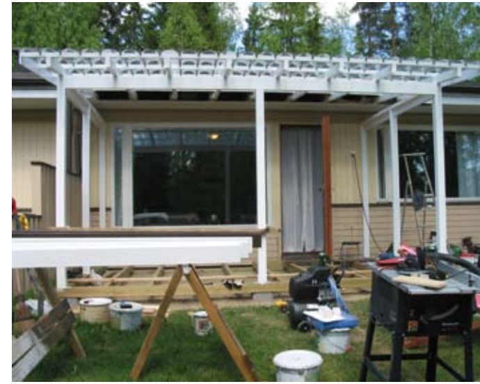
Rakentamisen ajan piha oli lievästi sanoen kaaottisessa kunnossa.
